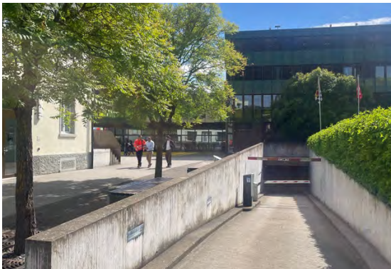
Tiefgaragenzufahrt zw. Kopfbau und Wohngebäude
