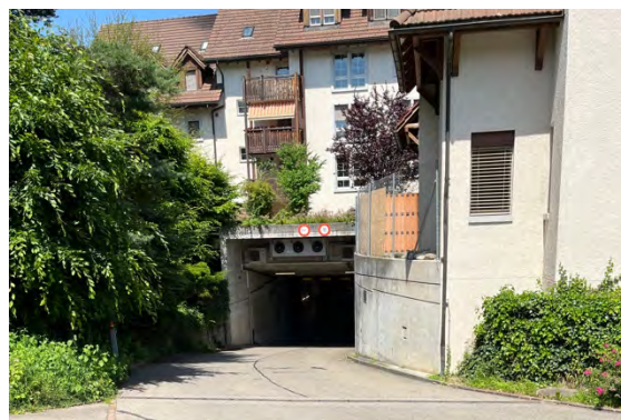
Ein- und Ausfahrt Tiefgarage seitens Zürichstrasse
